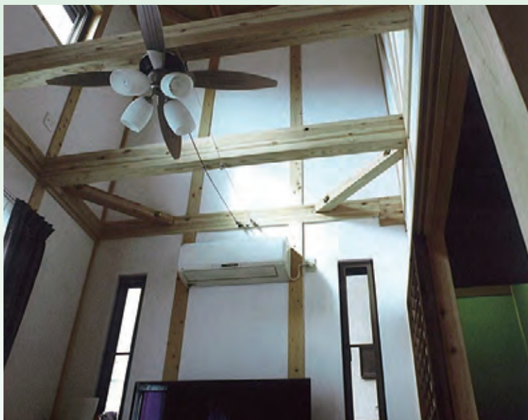
リビングの吹き抜け
