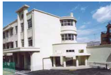
▲平成18年 現中央支所 初の耐震補強工事です。
