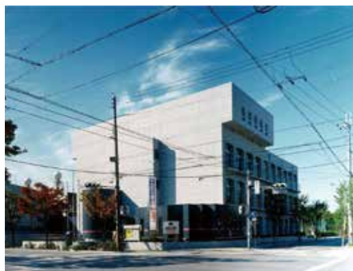
▼平成5年 尼崎市女性センター・トレピエ改修
