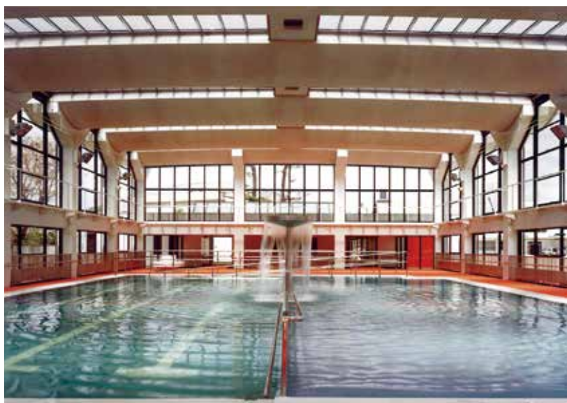
▲昭和59年 尼崎市立尼崎養護学校温水プール新築工事 昭和55年以降は、更に民間工事が冷え込んだ為、公共工事の仕事が多くなっていました。
