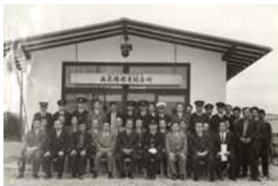
▲西昆陽巡査駐在所新築工事
