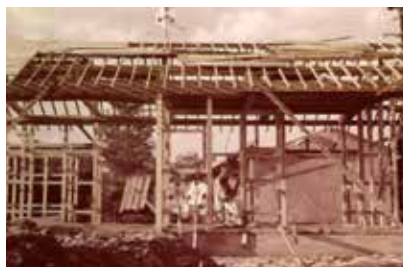
▲新築住宅の上棟
